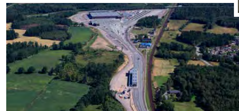
Det är här Öresunds- och Pågatågen rullar in för rengöring och reparation.
