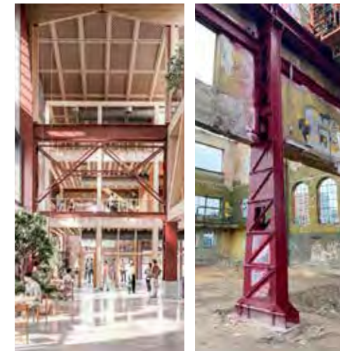
Gjuteriet, Varvsstaden. På gamla Kockumsområdet byggs 4600 m² kontor till Oatly. Ahnelövs Industrimålning har blåstrat stålkonstruktionen och brandskyddsmålat. Färg: Hempels brandskyddsfärg Hempafire Pro 315 FD, grundmålat med Hempadur Mastic 45880 och slutstrykning med Hempthane HS 55610.
